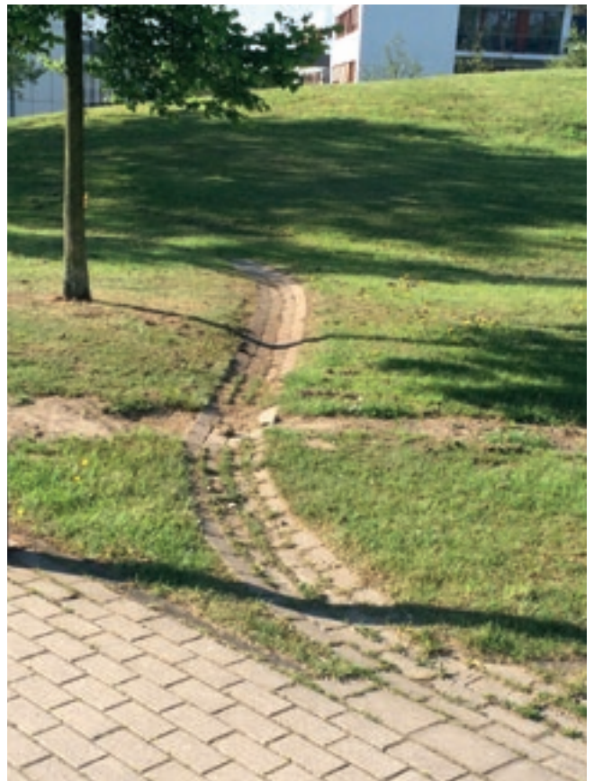
38 Ableitung über eine Muldenrinne auf eine Wiese
