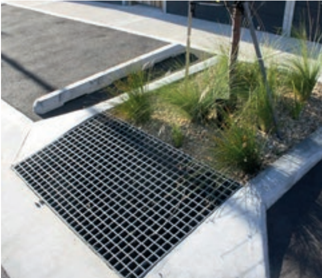
31 Einleitung wenig belasteter Straßenabflüsse in Pflanzgrube
