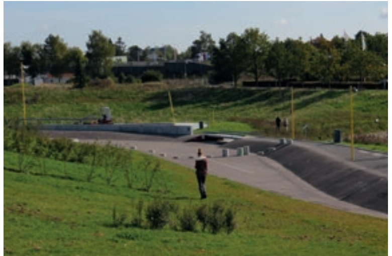
115 Zuleitung des Regenwassers auf Retentionsfläche
