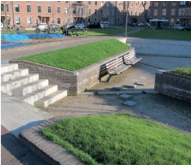
102 Bellamyplein im Trockenzustand
