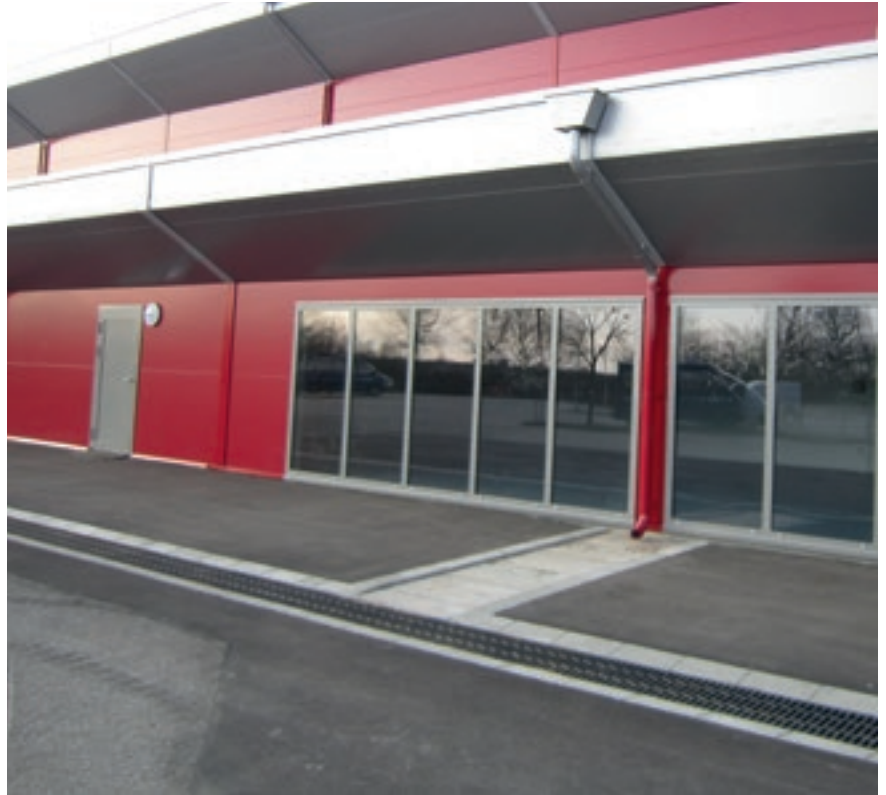
108 Sammelrinne am Tiefpunkt der Platzfläche (oben rechts)
