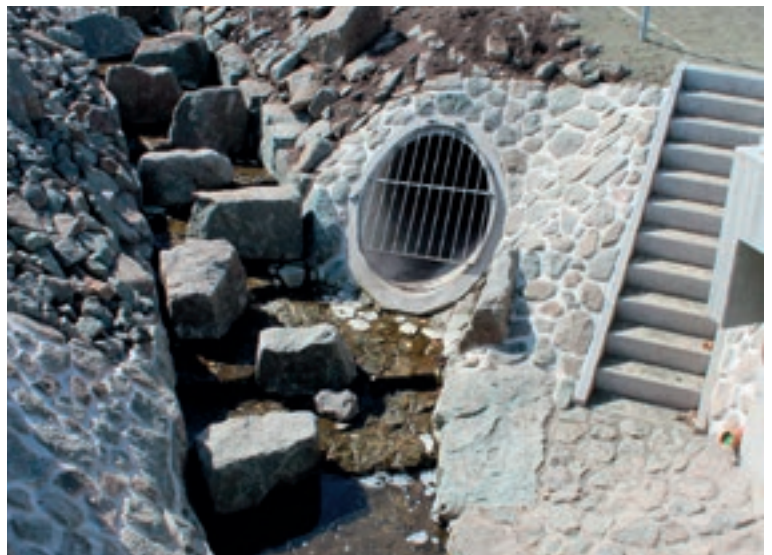
60 Zuleitung von Regenwasser in den Graben
