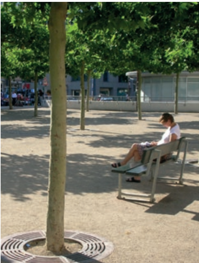
27 Platzfläche mit wassergebundener Decke
