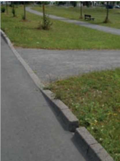
55 Ableitung von Straßenabflüssen in angrenzende Grünfläche über Wege und Schlitzborde
