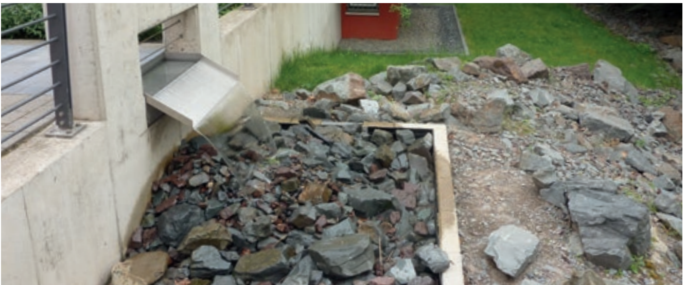
33 Ableitung von Gehwegabflüssen in eine Versickerungsanlage
