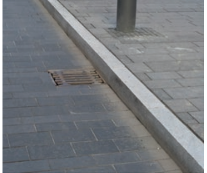
54 Erhöhte Bordsteine zur Verbesserung des Regenwasserabflusses
