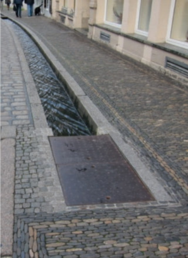
35 Permanente Wasserführung in offener Kastenrinne
