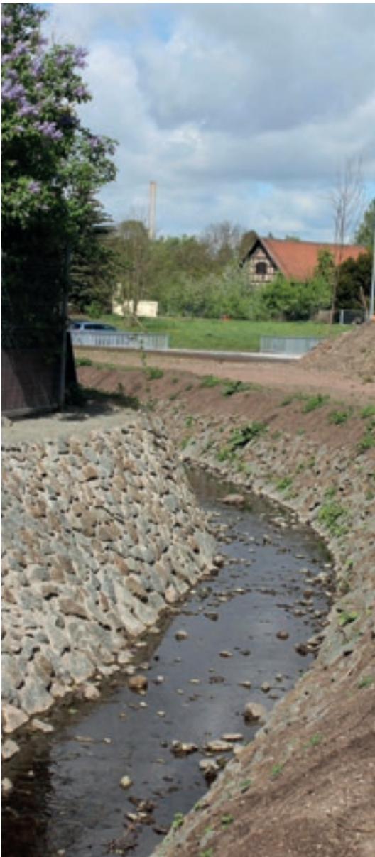
58 Reaktivierung eines ehemaligen Stadtgrabens
