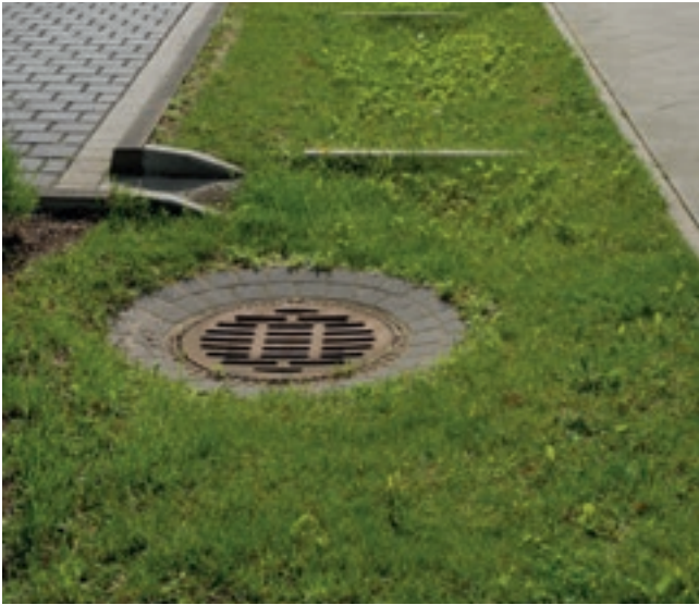
29 Dezentrale Straßenentwässerung über Muldenkaskaden
