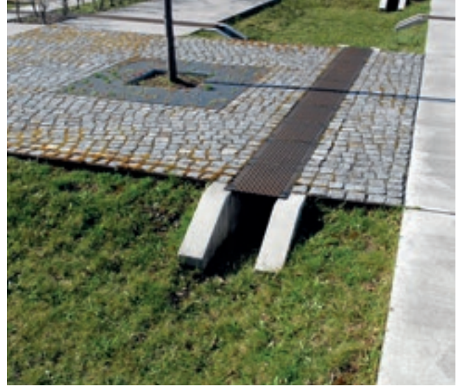
22 Detail eines Muldenzulaufes
