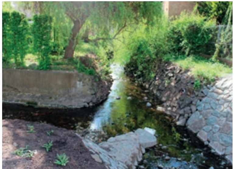
59 Graben mit zusätzlichen Retentionsmöglichkeiten
