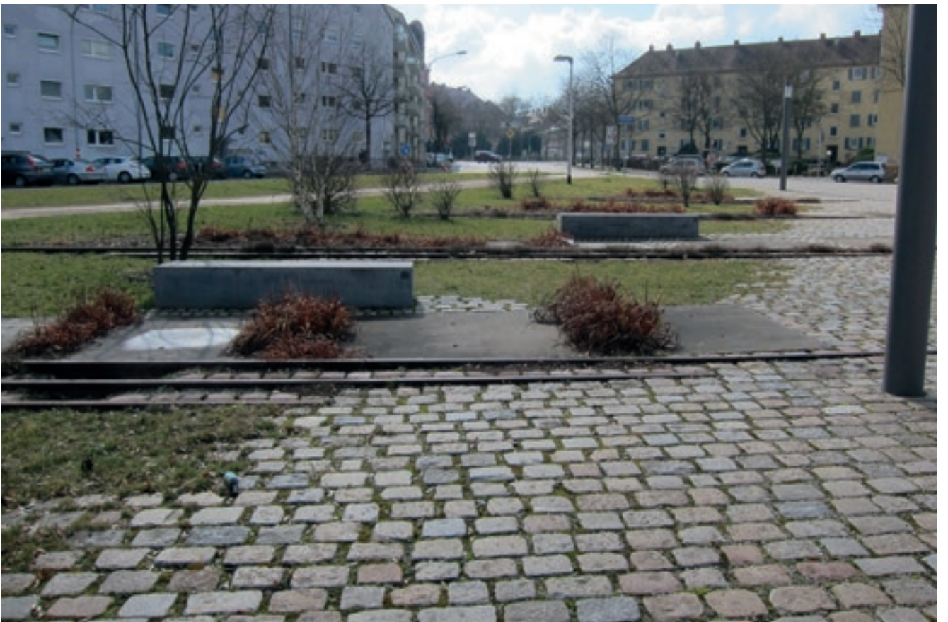
98 Versickerungsbeete und Fugenpflaster aus Naturstein
