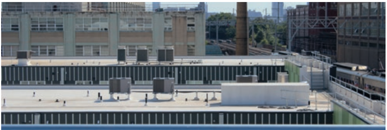
46 Dach mit erhöhter Regenauffang- und Rückhaltekapazität
