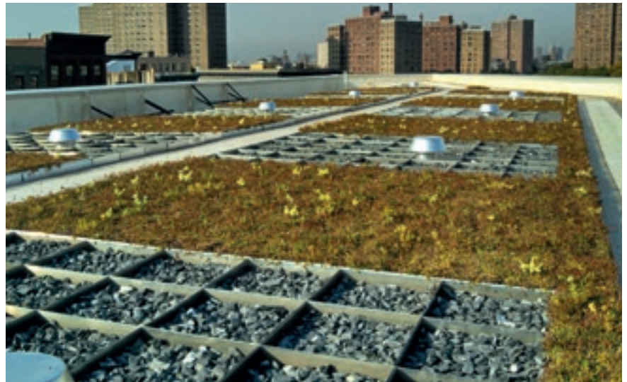
50 „Blaues Dach“ zum Rückhalt von Niederschlagsspitzen
