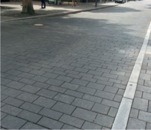
53 Abgesenkte Straße zum temporären Rückhalt von Abflussspitzen
