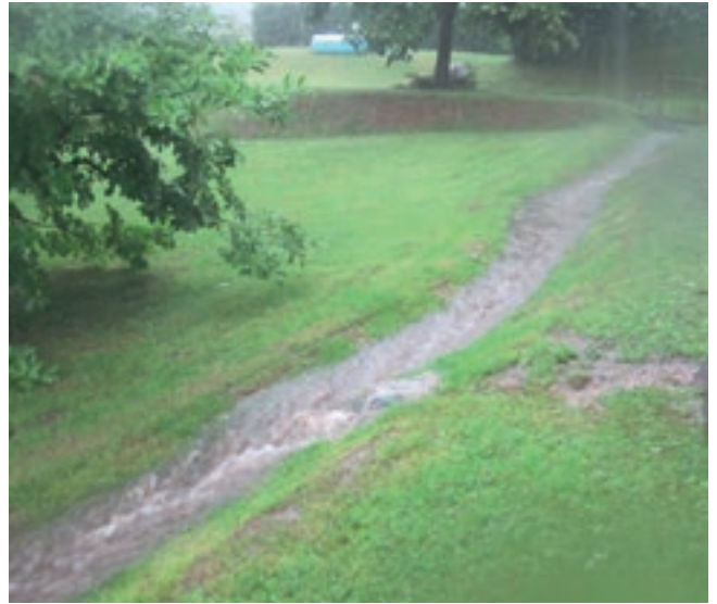
129 Entwässerungsmulde im Wohngebiet
